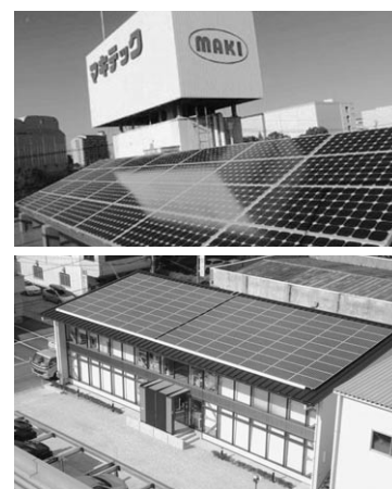
本社(上)、福岡事務所(下)に設置されたPVシステム
